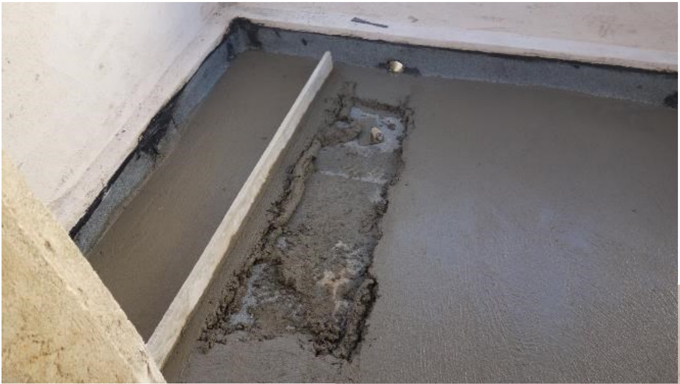
chape pour carrelage par-dessus l'étanchéité
