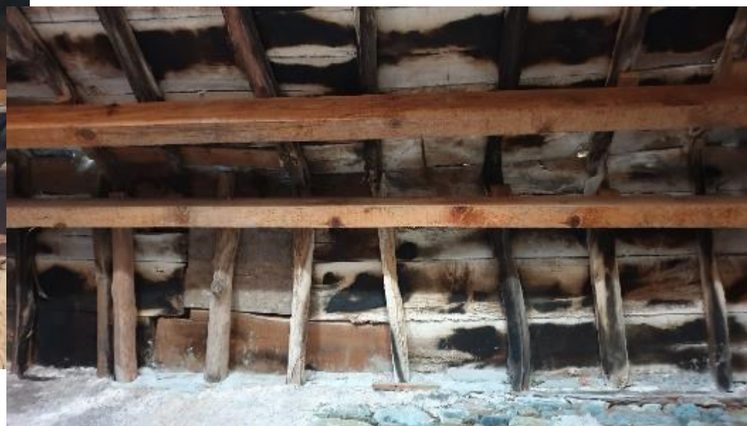
faîte et versant NO (place)
