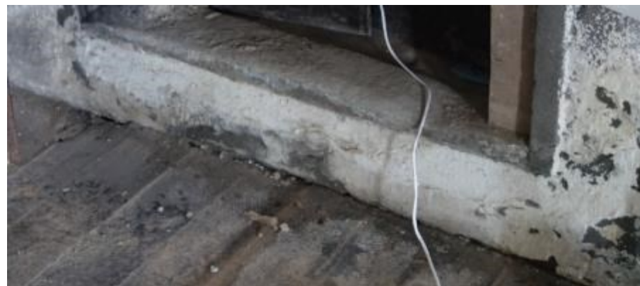
vers la grande pièce centrale
