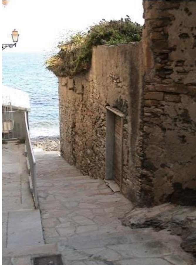
façades NE en 2017
