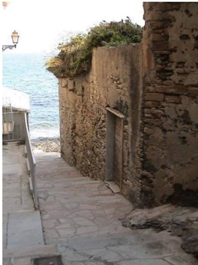
façades NE en 2017
