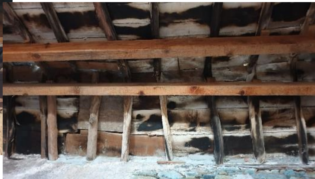
faîte et versant NO (place)
