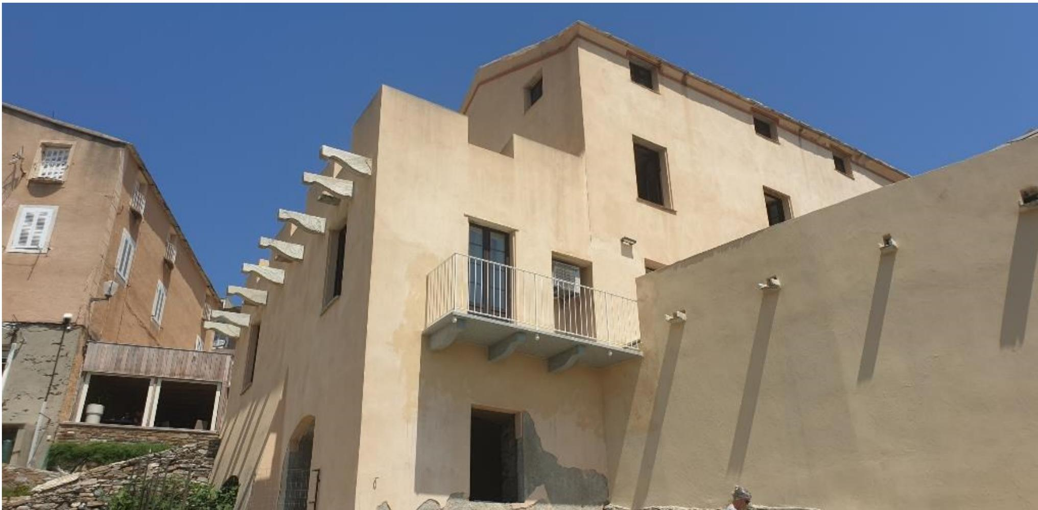
ce 3<sup>ème</sup> balcon est plus court de 80cm que celui d'origine, le 1<sup>er</sup>, qui arrivait presque à l'angle du mur, construit à la moitié du **XIX<sup>ème</sup>** siècle. Il est 40cm plus long que celui reconstruit en 2004, le 2<sup>ème</sup>, ce qui permettra d'ouvrir complètement les persiennes de la porte-fenêtre.
