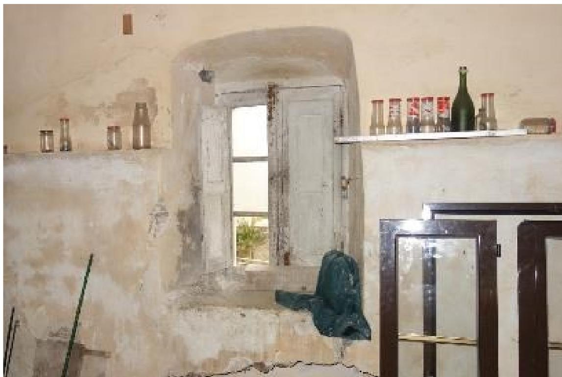
la pièce SO côté place est construite sur le rocher et a une cheminée en ardoise. La pièce SO côté mer a un plancher en bois. Le mur extérieur fait 85cm d'épaisseur.
