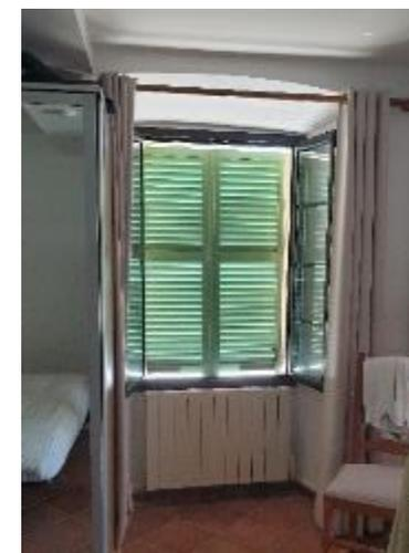
facilement accessibles par la terrasse, ces persiennes sont fixées de manière traditionnelle par des gonds en acier traités en cataphorèse avec scellement chimique ; des rondelles nylon complètent les charnières et un système de bloc-persienne permet de tenir les persiennes ouvertes sans se pencher ni recevoir la pluie pour les ouvrir ou les fermer.
