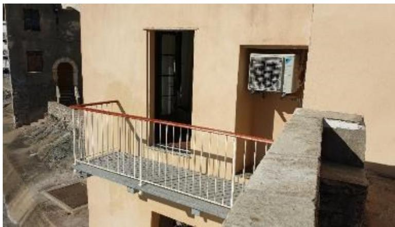
Pierre commande une main-courante pour le balcon, en fournissant un dessin du profil, arrondi, semblable à ceux des bastingages permettant de s'accouder confortablement quelle que soit sa taille.
