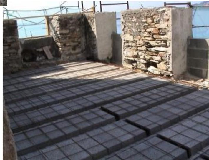
une dalle, avec chape et étanchéité, + isolations thermique et phonique, remplace le plancher écroulé...
