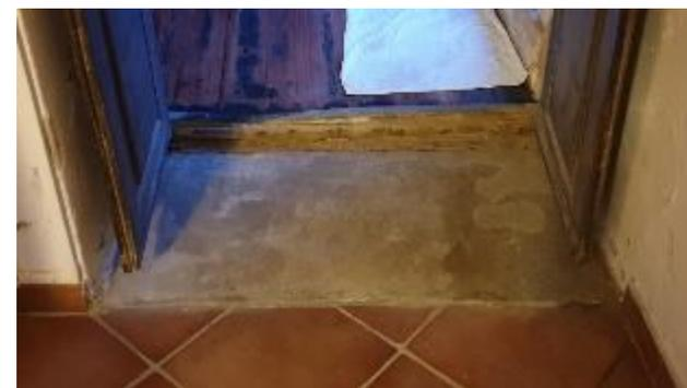
vers la pièce SE SO cette marche a été comblée par la dalle construite en 2004 en remplacement du plancher écroulé
