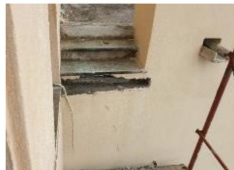
pour pallier à l'absence de mur en surplomb au-dessus de la console du milieu, une poutre traversière en béton armé est réalisée.
