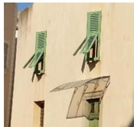
**13 juin** repose des persiennes de la fenêtre du palier 1<sup>er</sup> étage toutes vis, charnières et poignée remplacées en inox, bois poncé et 2 couches de peinture
