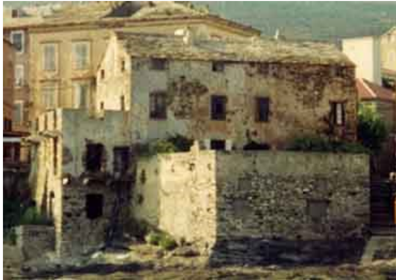
façades SE en 2001
