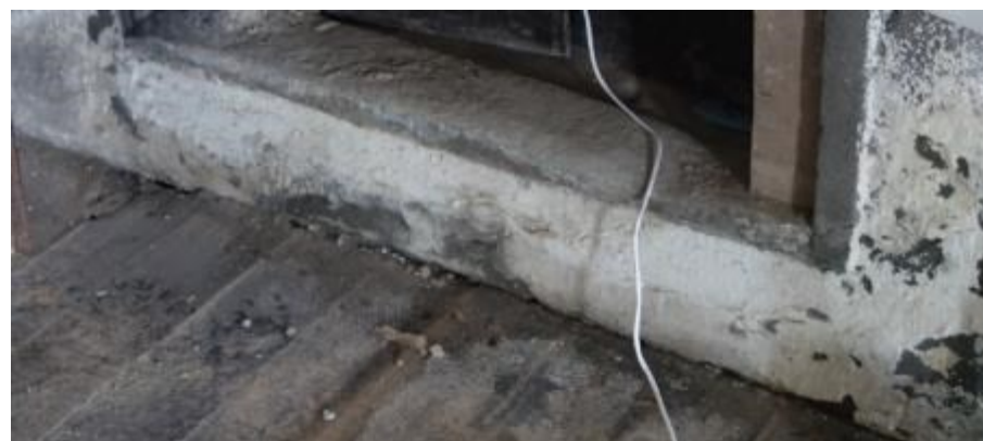
vers la grande pièce centrale
