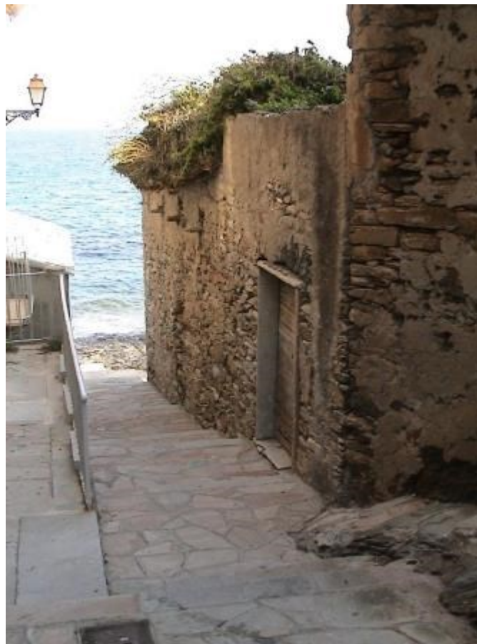
façades NE en 2017
