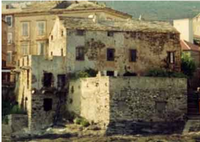
façades SE en 2001
