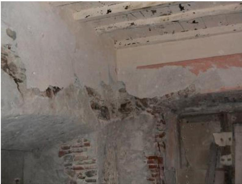
les plafonds de la chambre, de la cuisine et de la salle de bains sont de ce type : solives, plancher, chaux et tomettes.
