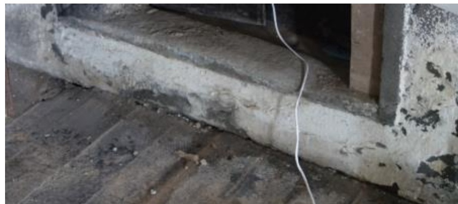
vers la grande pièce centrale
