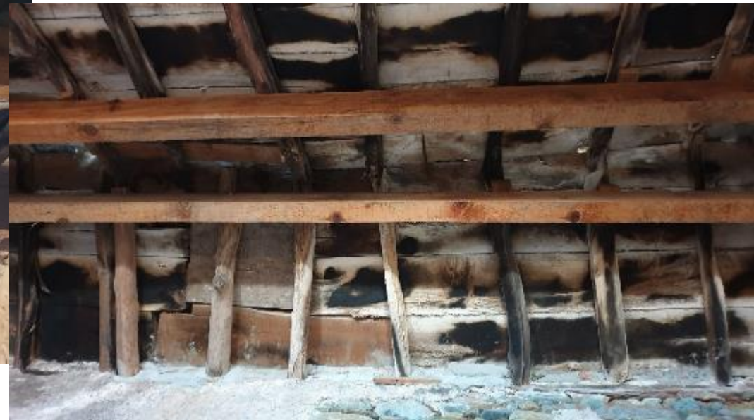
faîte et versant NO (place)
