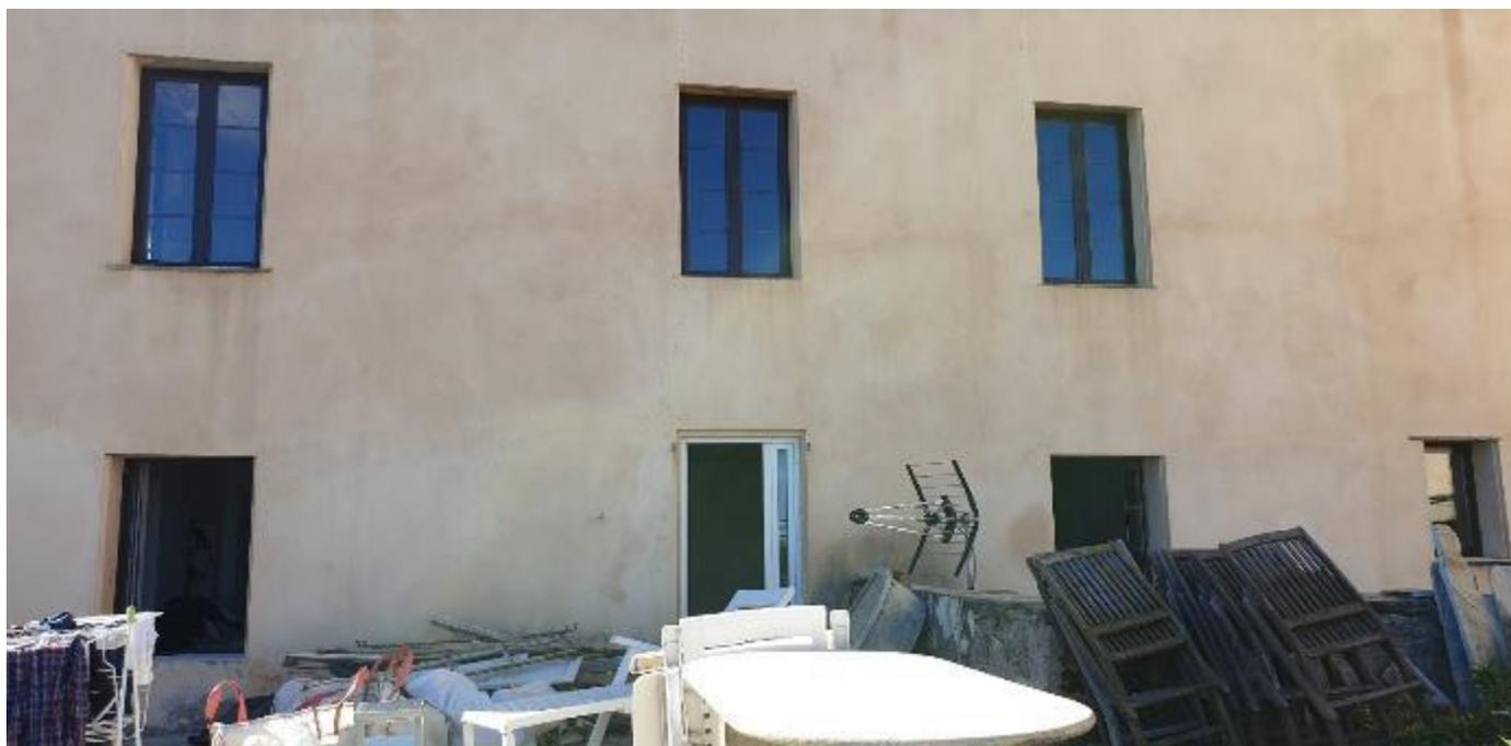
au rez-de-chaussée, la fenêtre donnant sur la cour ne nécessite pas de remplacement immédiat, elle date de la construction de la maison, vers 1790, et reste fonctionnelle. Ceci car elle est plutôt à l'abri des intempéries. Les volets intérieurs semblent avoir été rajoutés après coup d'après leurs targettes de fermeture ; comme le garde-corps à la ferronnerie semblable à plusieurs autres du voisinage immédiat et datant du **XIX<sup>ème</sup>**.
