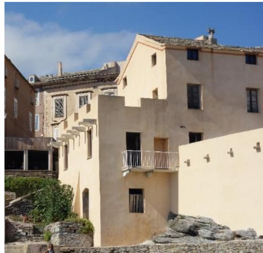
le balcon sera plus court de 1,20m environ car il allait presque jusqu'à l'extrémité du mur. En 2004 lors des travaux de rénovation des façades, le balcon est réalisé et un garde-corps en alu blanc est posé.
