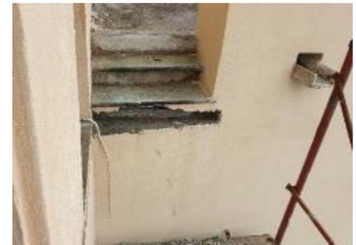
pour pallier à l'absence de mur en surplomb au-dessus de la console du milieu, une poutre traversière en béton armé est réalisée.
