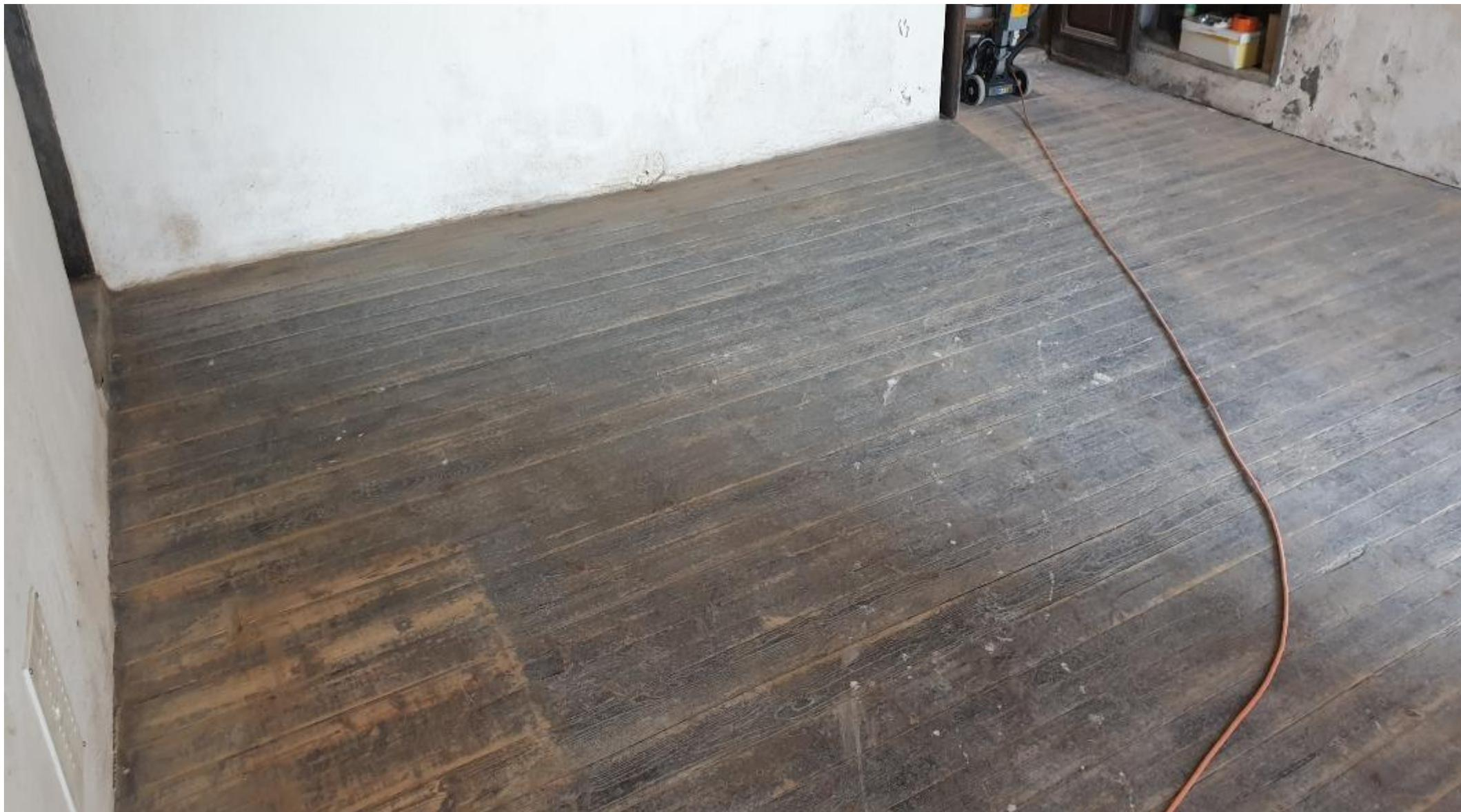
42 lames de 4,65m x 11,5cm apparents. Leur assemblage par rainure et languette a permis de conserver une parfaite planéité. Il y a aussi une cheminée en marbre noir.
