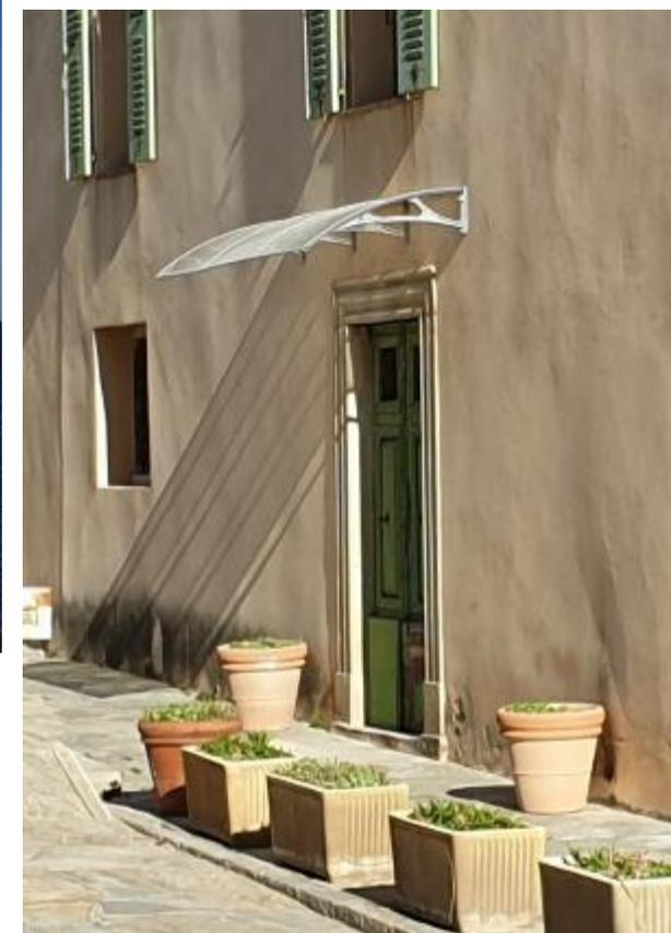
l'absence de gouttières fait que l'eau de pluie éclabousse les soubassements. La porte d'entrée a vu ainsi ses panneaux inférieurs détruits, ils sont présents sur la photo de 1913, mais ils sont remplacés par des panneaux plats sur la photo de 1920
