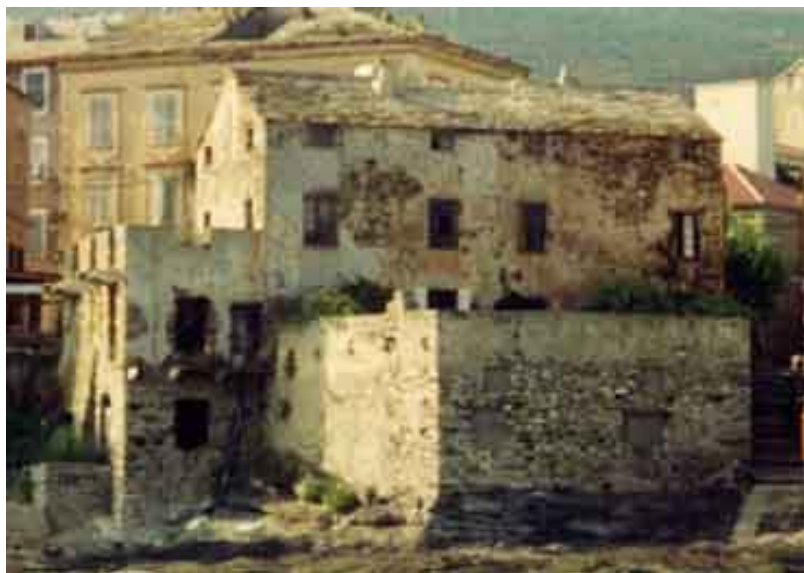
façades SE en 2001
