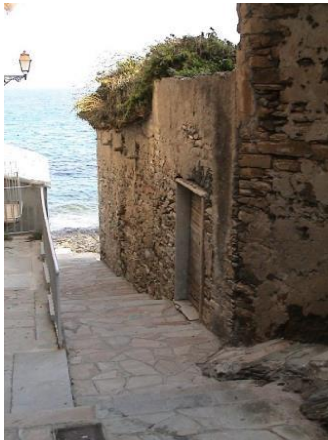
façades NE en 2017
