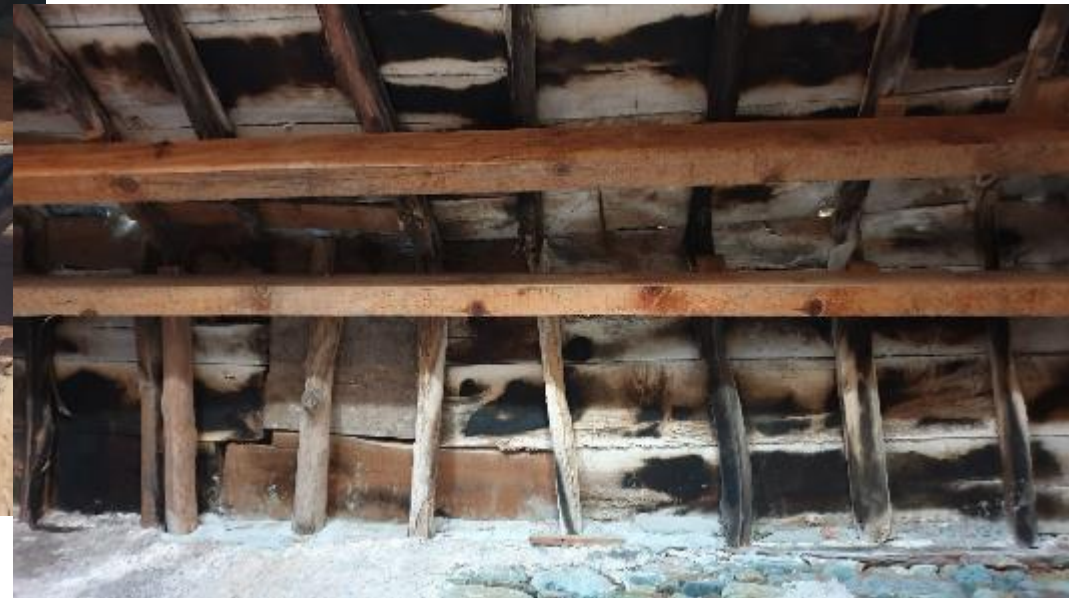
faîte et versant NO (place)
