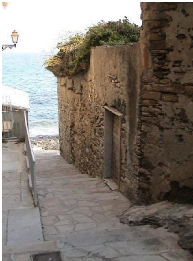
façades NE en 2017
