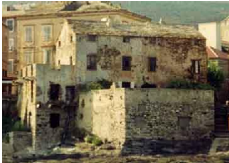
façades SE en 2001
