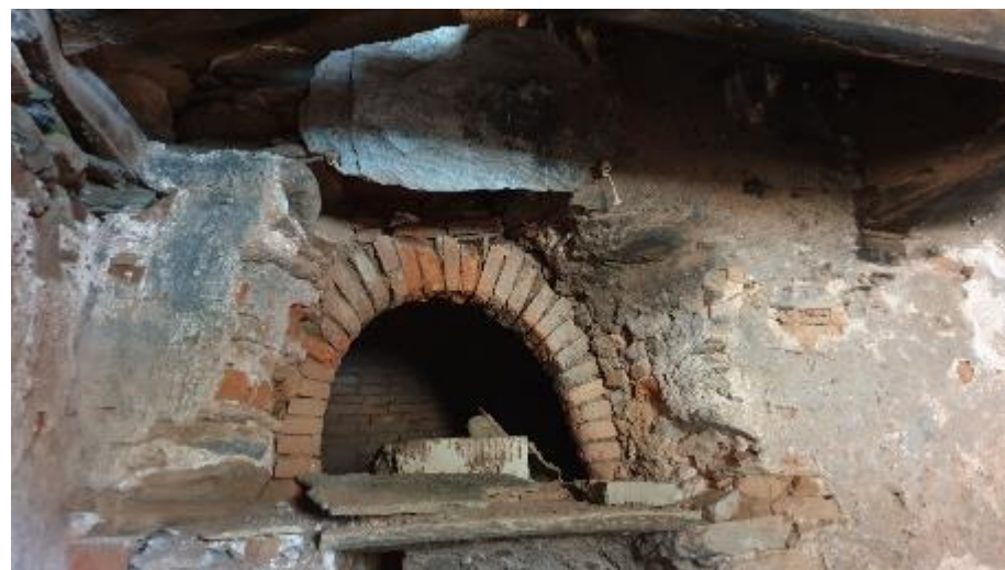
le refouloir de fumée
