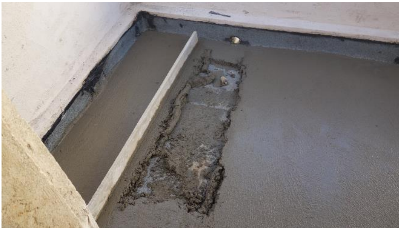
chape pour carrelage par-dessus l'étanchéité
