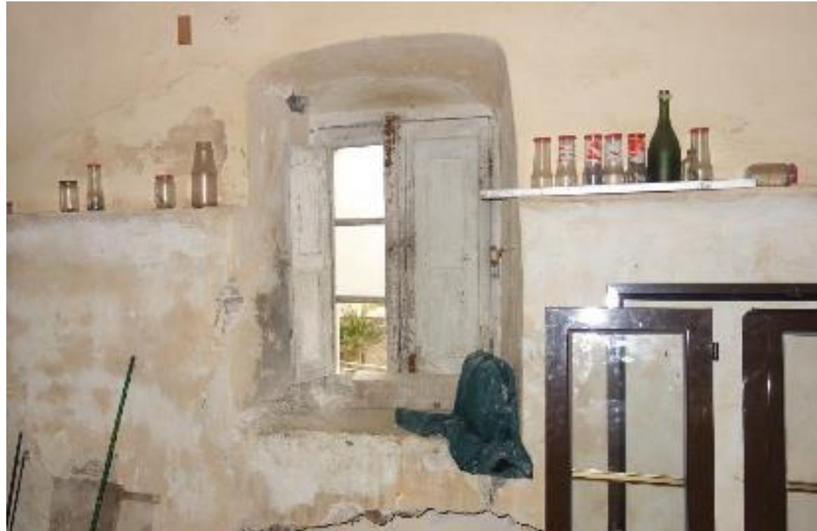
la pièce SO côté place est construite sur le rocher et a une cheminée en ardoise. La pièce SO côté mer a un plancher en bois. Le mur extérieur fait 85cm d'épaisseur.
