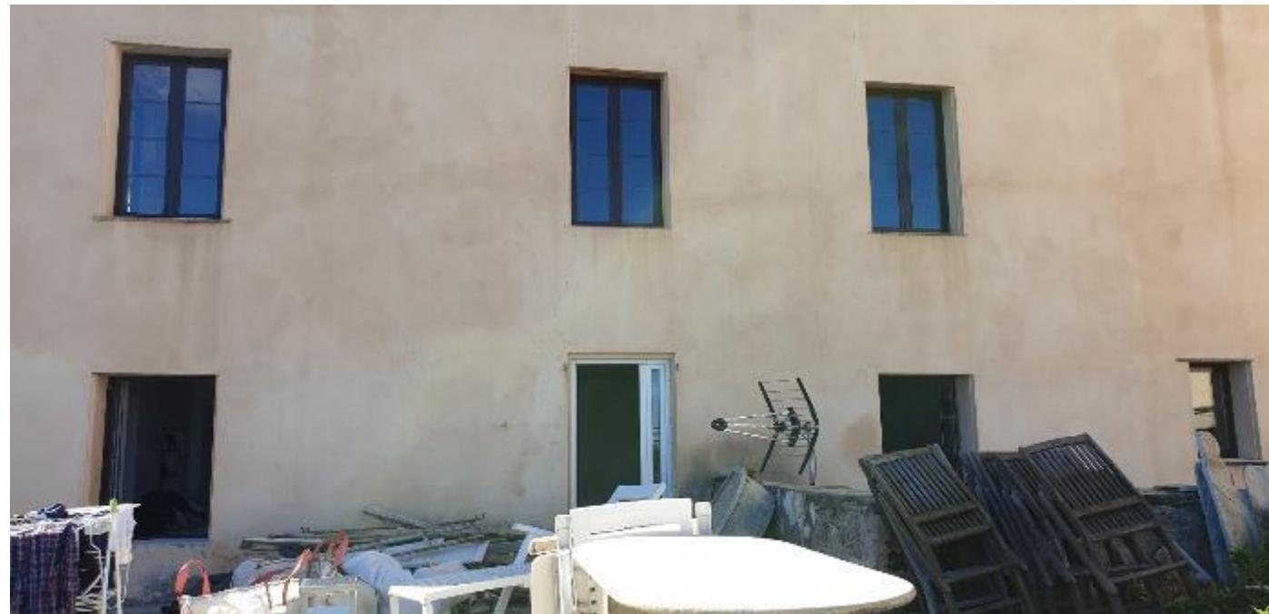
au rez-de-chaussée, la fenêtre donnant sur la cour ne nécessite pas de remplacement immédiat, elle date de la construction de la maison, vers 1790, et reste fonctionnelle. Ceci car elle est plutôt à l'abri des intempéries. Les volets intérieurs semblent avoir été rajoutés après coup d'après leurs targettes de fermeture ; comme le garde-corps à la ferronnerie semblable à plusieurs autres du voisinage immédiat et datant du **XIX<sup>ème</sup>**.
