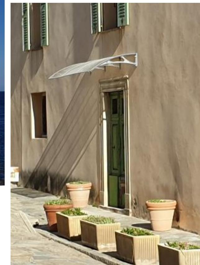
l'absence de gouttières fait que l'eau de pluie éclabousse les soubassements. La porte d'entrée a vu ainsi ses panneaux inférieurs détruits, ils sont présents sur la photo de 1913, mais ils sont remplacés par des panneaux plats sur la photo de 1920
