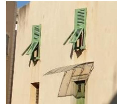
**13 juin** repose des persiennes de la fenêtre du palier 1<sup>er</sup> étage toutes vis, charnières et poignée remplacées en inox, bois poncé et 2 couches de peinture
