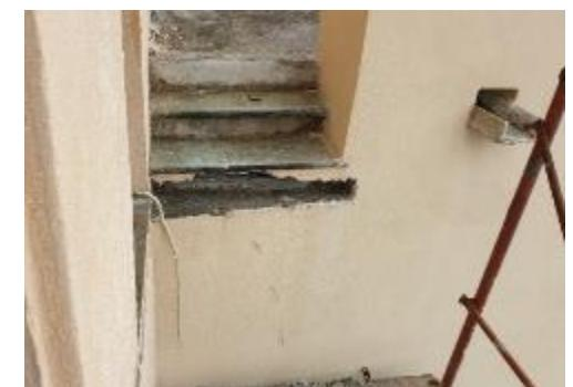
pour pallier à l'absence de mur en surplomb au-dessus de la console du milieu, une poutre traversière en béton armé est réalisée.
