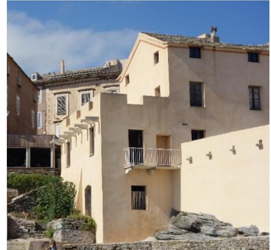
le balcon sera plus court de 1,20m environ car il allait presque jusqu'à l'extrémité du mur. En 2004 lors des travaux de rénovation des façades, le balcon est réalisé et un garde-corps en alu blanc est posé.
