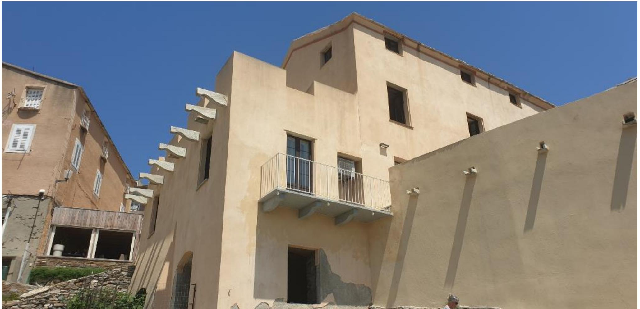
ce 3<sup>ème</sup> balcon est plus court de 80cm que celui d'origine, le 1<sup>er</sup>, qui arrivait presqu'à l'angle du mur, construit à la moitié du **XIX<sup>e</sup> siècle**. Il est 40cm plus long que celui reconstruit en 2004, le 2<sup>ème</sup>, ce qui permettra d'ouvrir complètement les persiennes de la porte-fenêtre.
