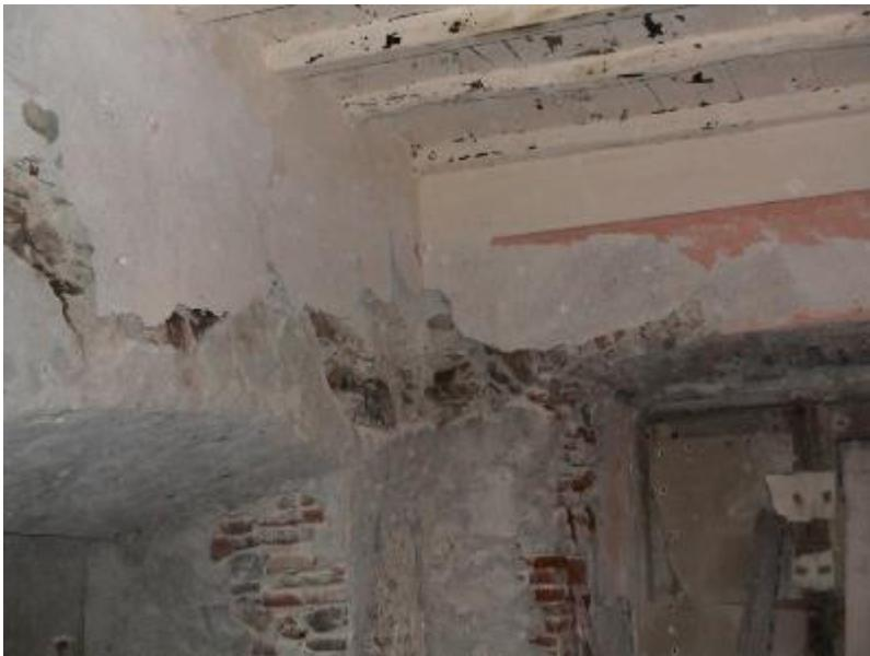
les plafonds de la chambre, de la cuisine et de la salle de bains sont de ce type : solives, plancher, chaux et tomettes.
