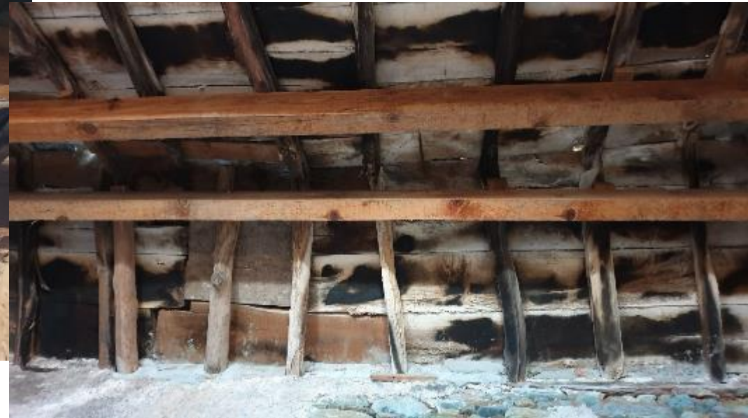
faîte et versant NO (place)
