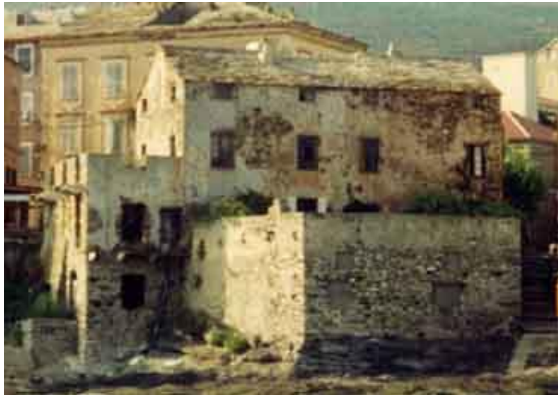
façades SE en 2001
