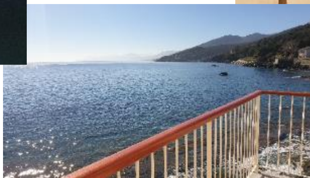
main courante posée le 7 février 2020
