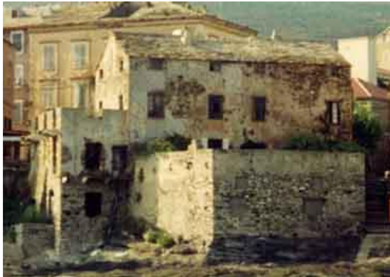
façades SE en 2001
