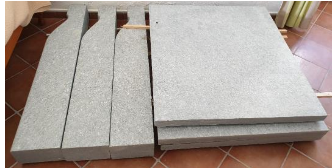
la reconstruction du balcon commence le 16 mai 2019.
