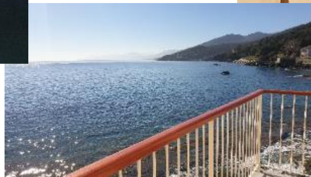
main courante posée le 7 février 2020
