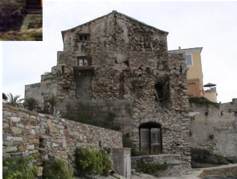
façade NO en 2003
