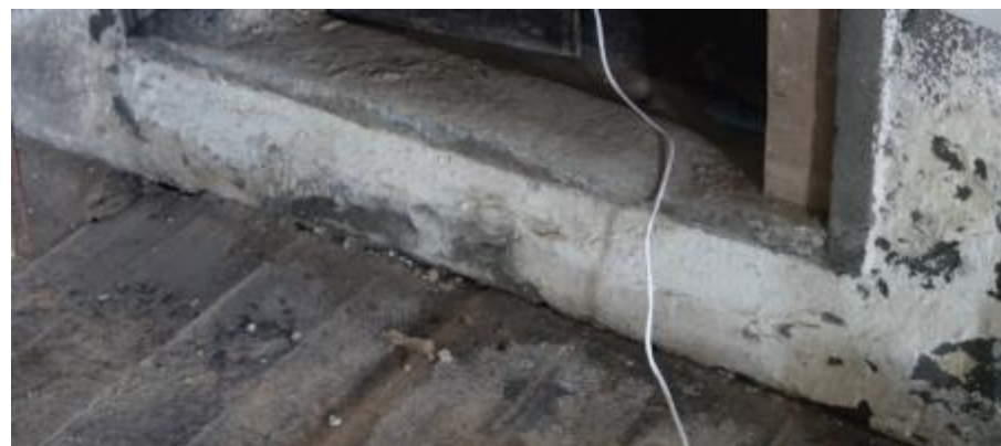
vers la grande pièce centrale
