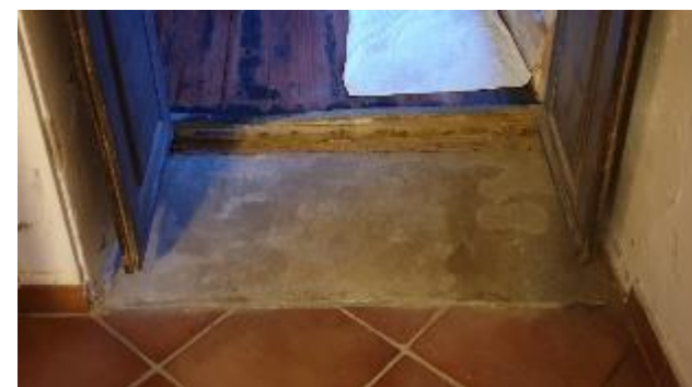
vers la pièce SE SO cette marche a été comblée par la dalle construite en 2004 en remplacement du plancher écroulé
