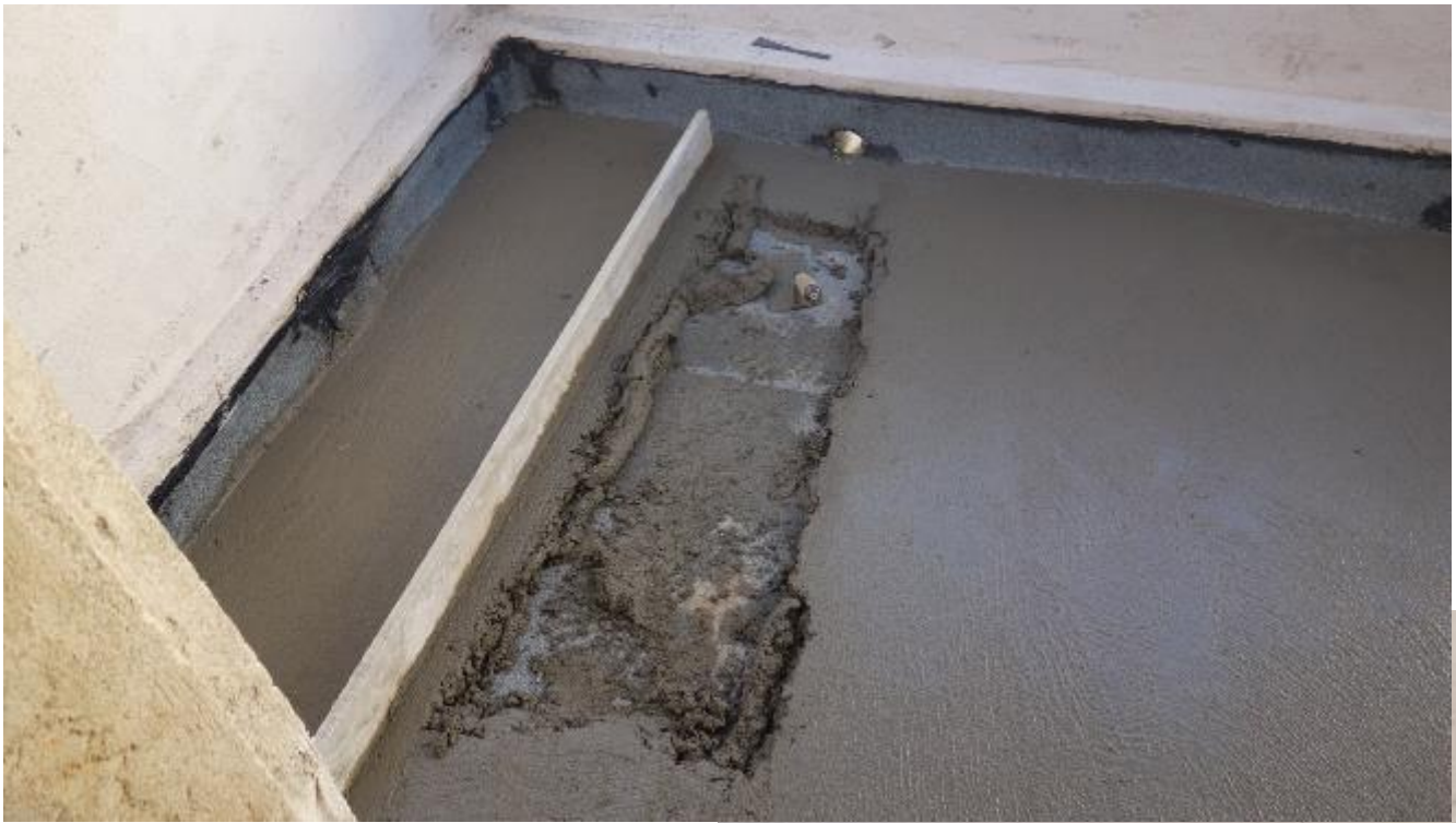
chape pour carrelage par-dessus l'étanchéité
