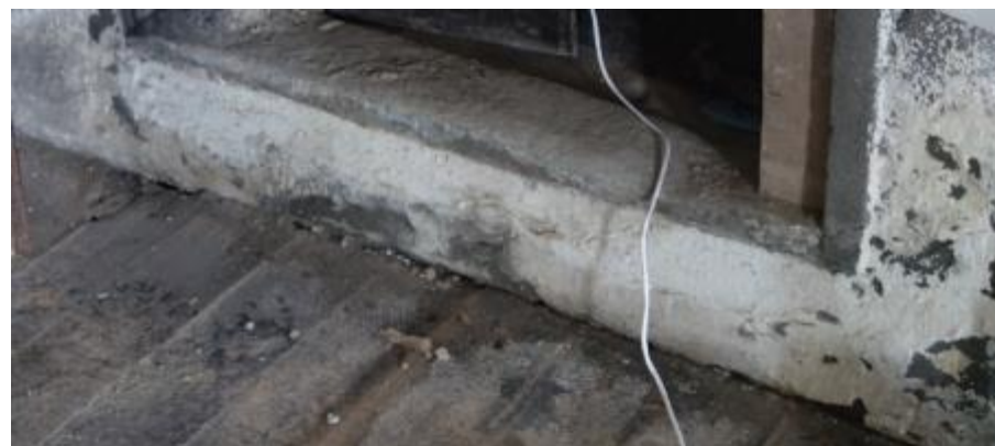
vers la grande pièce centrale
