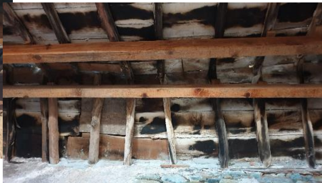
faîte et versant NO (place)
