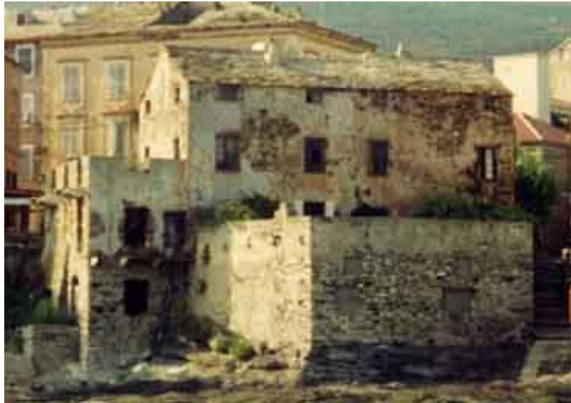
façades SE en 2001
