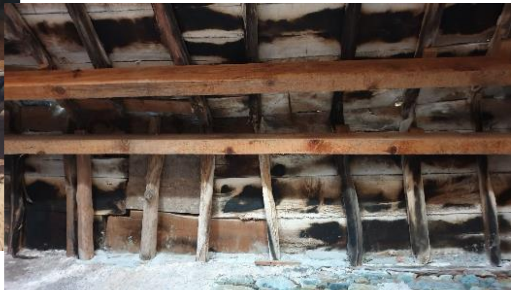
faîte et versant NO (place)
