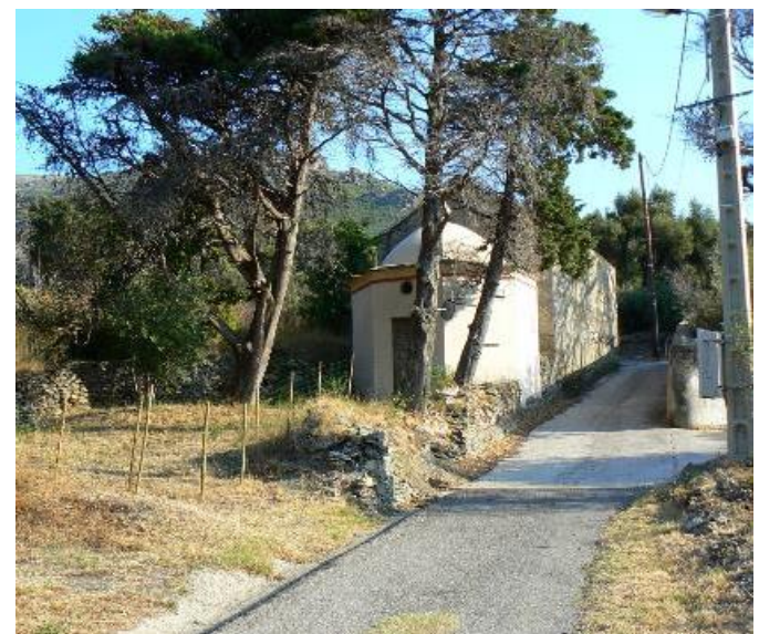
le tombeau après sa restauration de 2002 (photo du 10/8/2006)
